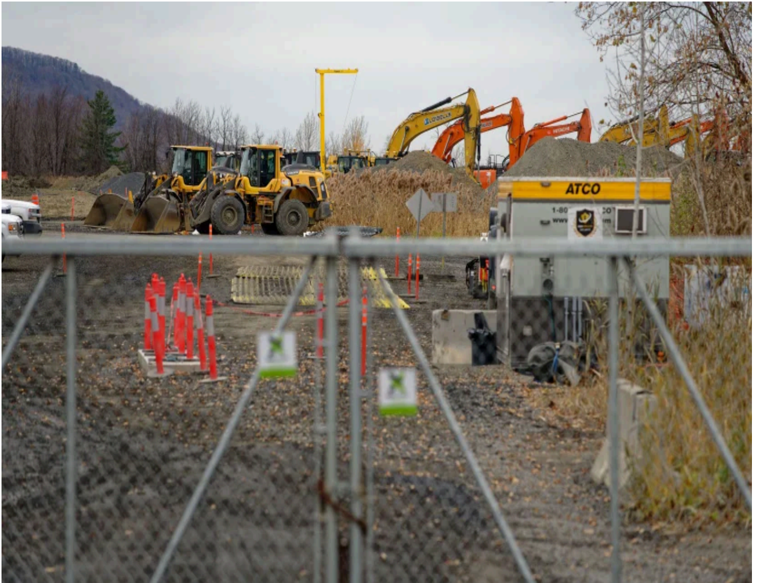
Photo: Olivier Zuida Le Devoir Le chantier de Northvolt en novembre 2024
